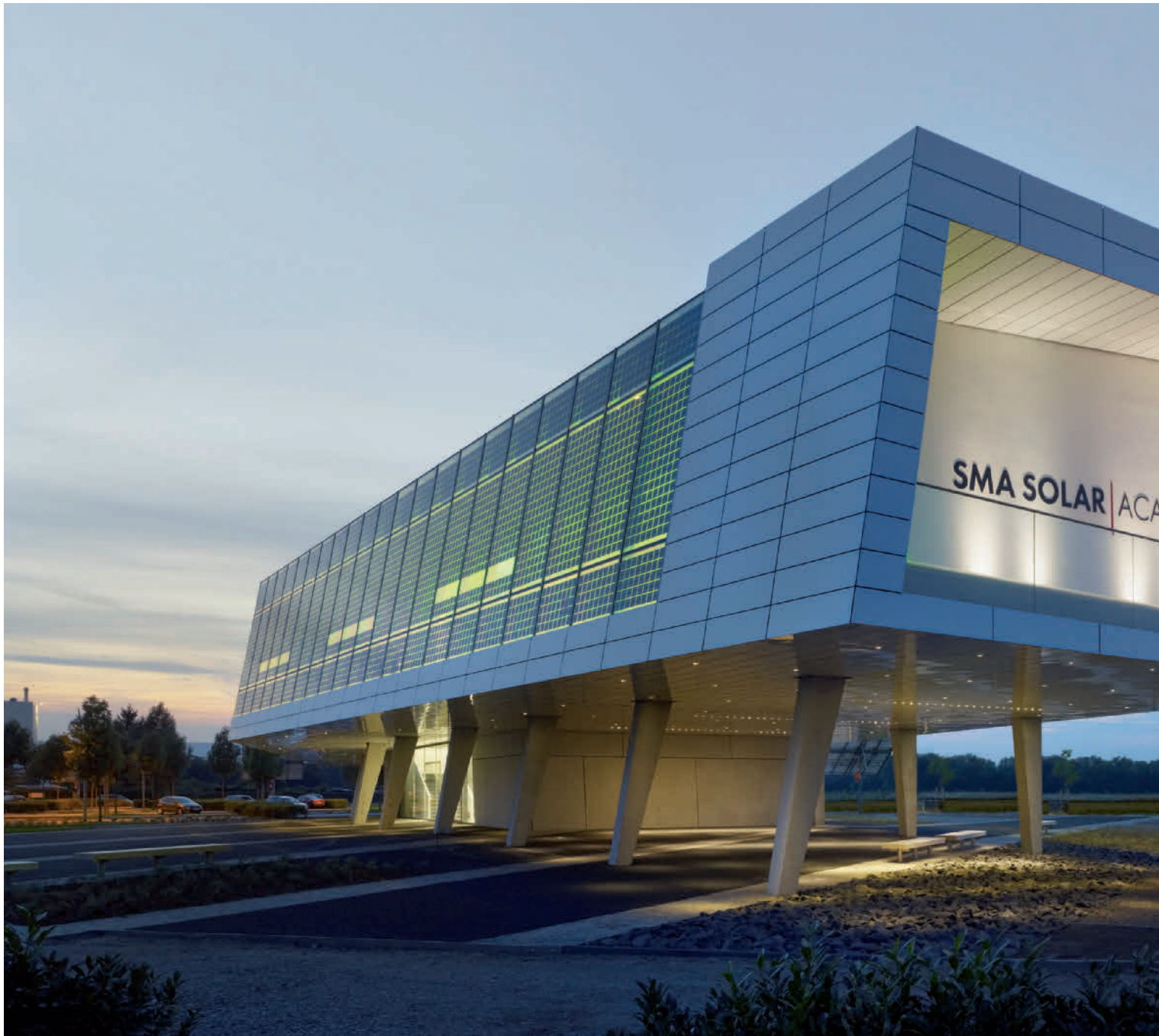
Schulungszentrum, Niestetal, Hegger Hegger Schleiff HHS Planer+Architekten AG, Kassel, © Constantin Meyer, Köln
