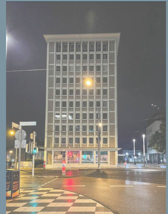
03 // Blick auf das Jugendamt (EAM-Hochhaus)
